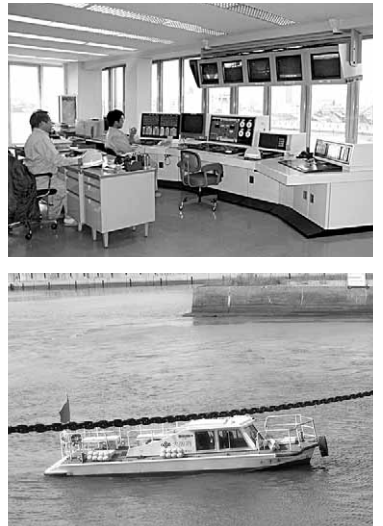
水門の開閉操作をコントロールする監視操作室(上)と付近の船舶を監視する大阪府の監視船
