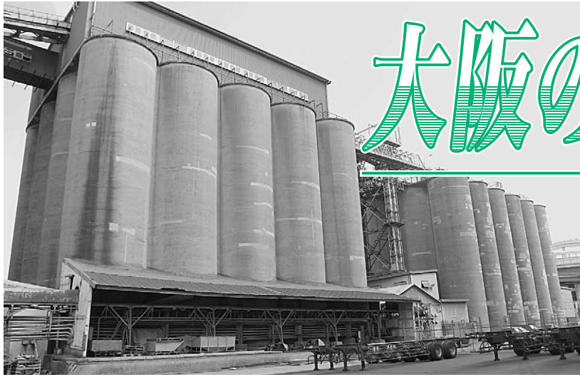
〈写真①〉半世紀以上にわたり府民に食糧を安定供給してきた大阪港サイロ施設。円筒形のユニークな形状には先人の想いと知恵が込められている
