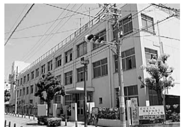
港区の学校園施設の耐震状況
